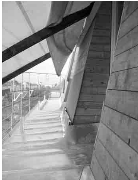
Prenzlauer Allee: Blick auf eine Terrasse im Dachgeschoss
