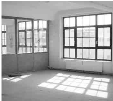
Glogauer Straße 19 a/b, 21: Innenansicht Fabriketage
